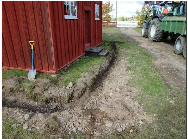
Kellorakennuksen luoteis- ja koillisivustalle kaivettu salaoja.
