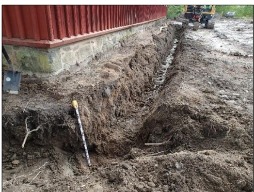
Vasemmalla salaojakaivanto päärakennuksen lounaisella seinällä. Kuvattu kaakkoon päin. Oikealla pihan pintamaata kuorittiin paikoitellen vain noin 20 cm paksuudelta.
