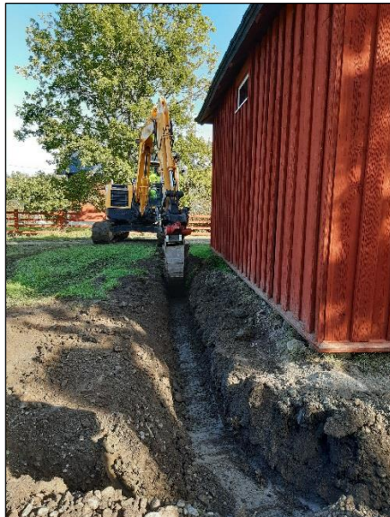
Kellorakennuksen luoteis- ja koillisivustalle kaivettu salaoja.
