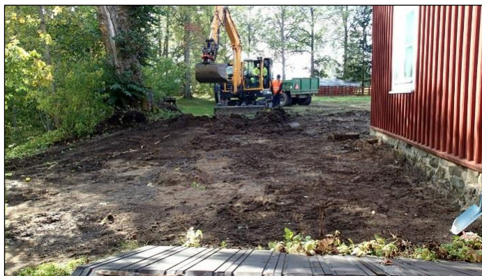
Vasemmalla päärakennuksen luoteispuolen kuorittua ja tasoitettua pihamaata. Oikealla pintamaiden poistoa ja muokkausta Ylipytingin kaakkoispäässä.
